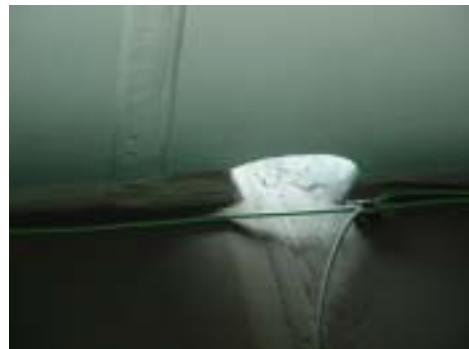
사진 1 경부선 고속철도 2주형 강교량 현장용접 사례
