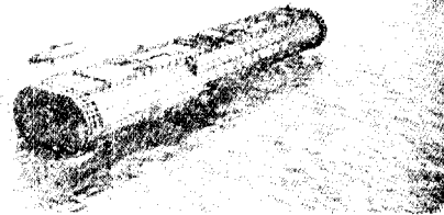
일본 京浜지구에 沈設된 沈埋 Tunnel 전체沈埋 Tunnel 328m의 4분할한 부분으로 높이: 8m, 폭: 13m, 중량: 2,440t 그림 12. 曳航中の 沈埋 Tunnel 2)
